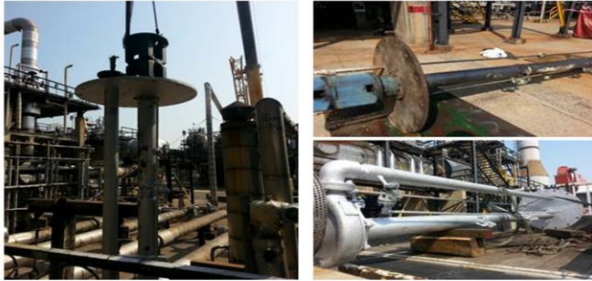
NO.1 FCC SR-P3516 PUMP 교체 작업
