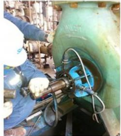
정유기계2 T/A 사전작업 TG-FA8601 Seal type 변경 작업
