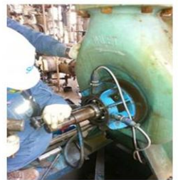
정유기계2 T/A 사전작업 TG-FA8601 Seal type 변경 작업
