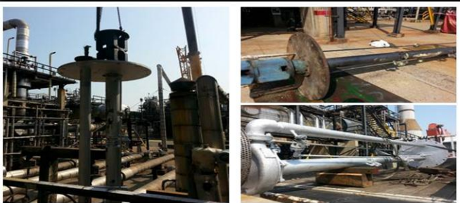
NO.1 FCC SR-P3516 PUMP 교체 작업
